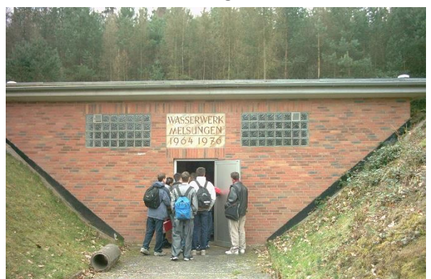
Eingang zum Hochbehälter Melsungen
