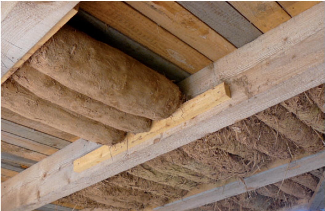
Lehmwickel (Stake, Einschubholz)
