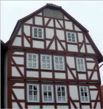
Brückenstraße 17 (gebrochenes Dach – Mansarde)
