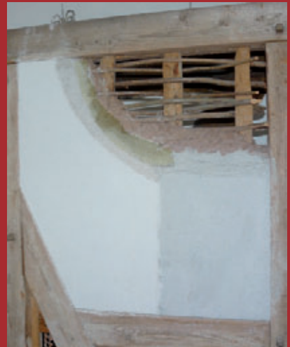
Aufbau einer Ausfachtung
