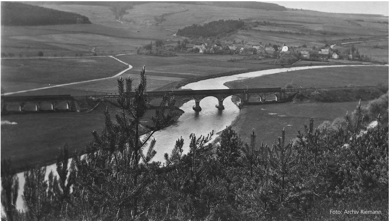
Die Eisenbahnbrücke bei Obermelsungen
