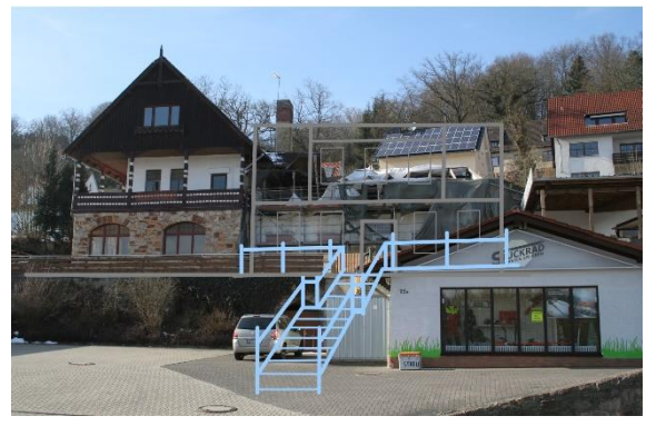
Links: Anbau an dem eigentlichen Hause „Rosengarten“ linkes Haus mit Sockel aus Natursteinen . Der besseren Übersicht, eine Fotomontage mit dem Haus „Rosengarten“ und dem Treppenaufgang.
