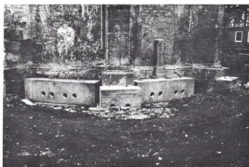
*Die sogenannten „Streichbalken“ sind innen und außen angelegt; sie werden durch die Fundamente hindurch hydraulisch verspannt. Sie nehmen so die Mauerlast auf und tragen sie über die 150 senkrechten 8–10 m langen „Wurzelstäbe“ in die festen Bodenschichten ab. (156)*
