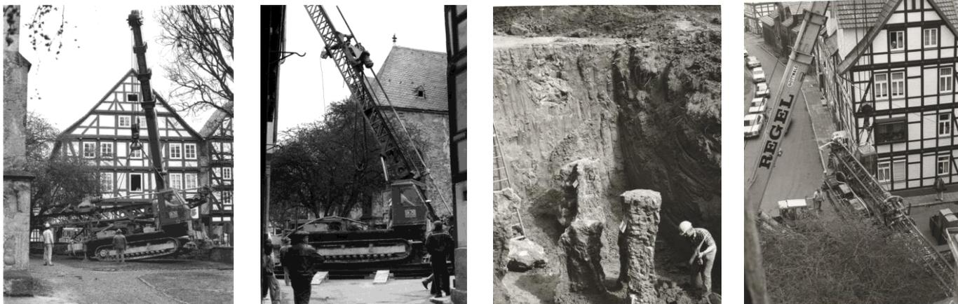
Probebohrungen und Injektionen bis zu 6 m Tiefe
