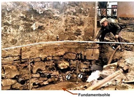
Ob man bei dieser Bauweise von Fundamenten aus heutiger Sicht sprechen kann? Auf dem Bild sieht man schon die Schraubenanker für die Streichbalken.
