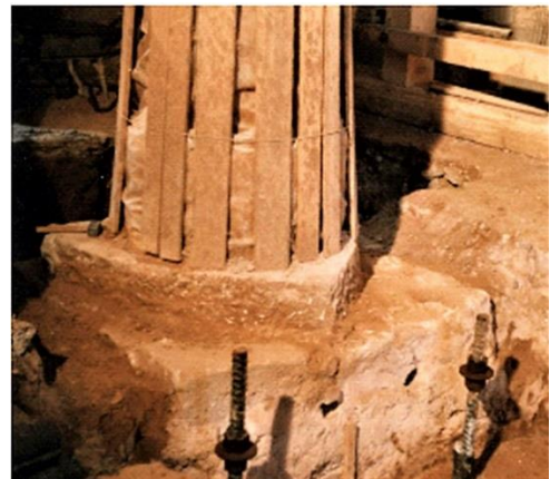
Freigelegte Grundfundamente der Säulen viereckig rund dreieckig
