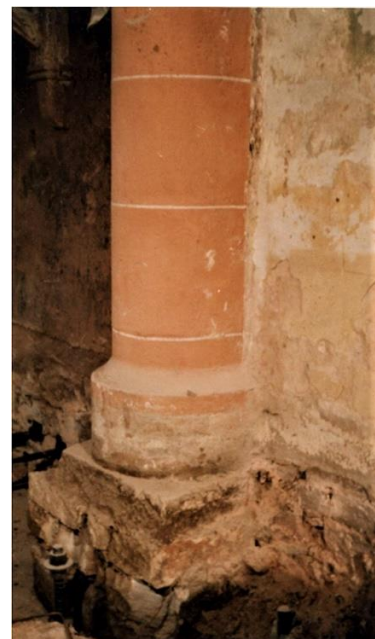
Freigelegte Grundfundamente der Säulen viereckig rund dreieckig
