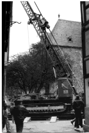
Probebohrungen und Injektionen bis zu 6 m Tiefe
