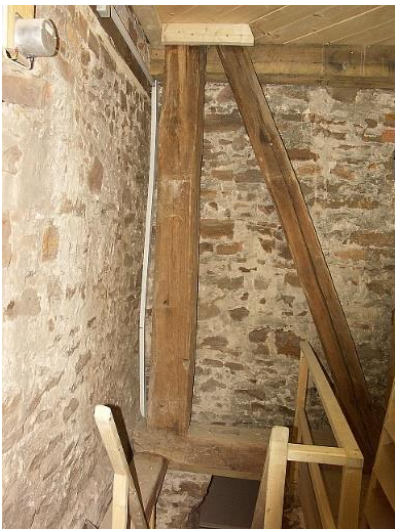
Im 3. Obergeschoss sieht man, dass die Balken in einem Abstand von der Wand aufgestellt sind. Die Streben stehen in Nord-Süd-Richtung. Die Glocken schwingen in Ost-West-Richtung.
