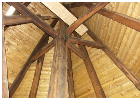
Die Streben der Balkenknoten stützen die Sparren des 5/8 Chorabschlusses.
