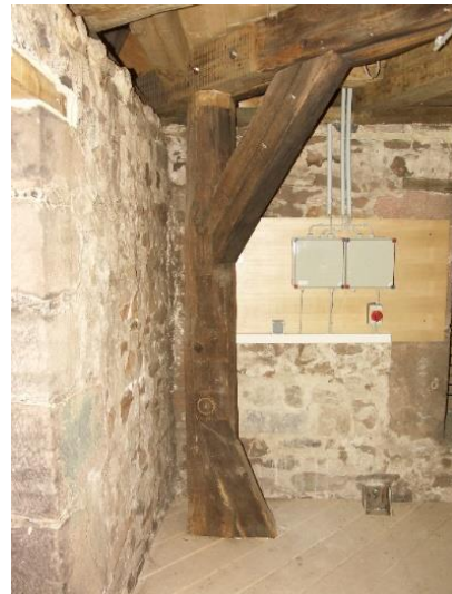
Auch im 4. Obergeschoss stehen die Balken im Abstand von den Wänden. Dadurch kann der oben sichtbare Glockenstuhl beim Läuten der Glocken schwingen ohne dass dessen Schwingungen auf das Mauerwerk übertragen werden und dieses zerstören.
