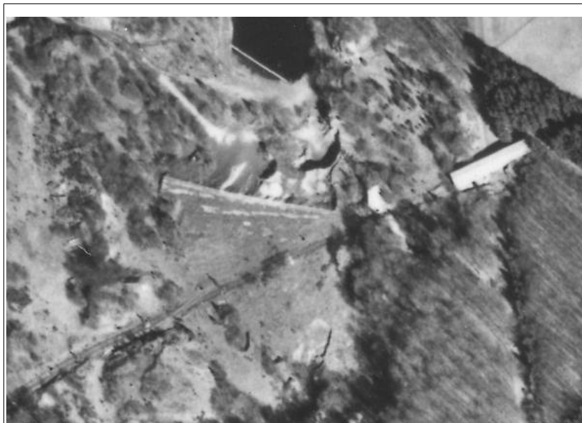
Luftbild von den Seilbahnanlagen am Grünen See. Diagonal von links unten nach rechts oben - die Seilbahn. Rechts oben - die Spannstation, in der Mitte - die Abfallhalde. Luftbildarchiv beim Landesamt für Bodenmanagement und Geoinformation vom 01. 04. 1960
