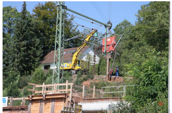
Strommasten werden neu gestellt und die Spundwände für den Bahnsteig zur HUBERG-Seite gesetzt
