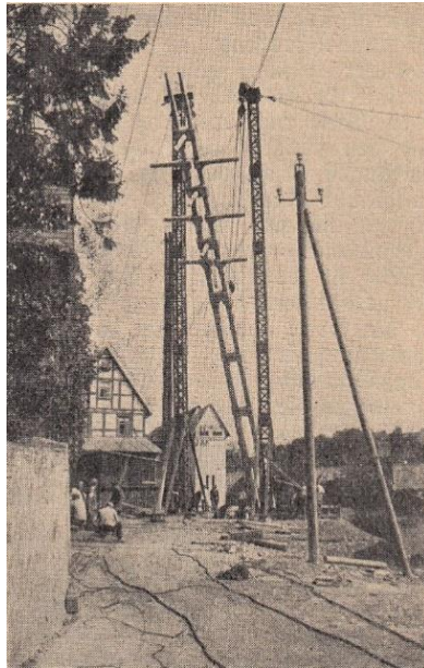
Zum Anschluss des Städtischen Elektrizitätswerks Melsungen an das Überlandwerk Edertalsperre. Aufstellung des Hauptmastes am FENNERS HOF Quelle: JKM 1926
