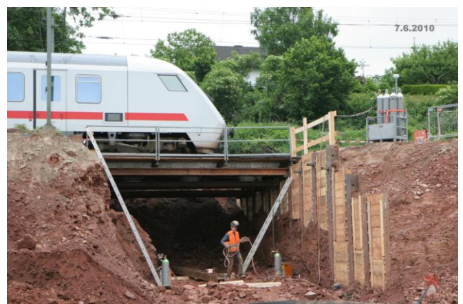
...bei weiterlaufendem Schienenverkehr
