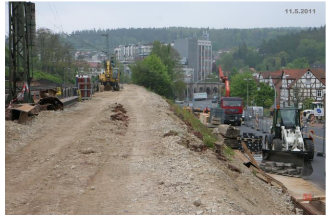
...aber nun ist es ernst, die Bauarbeiten laufen voll an
