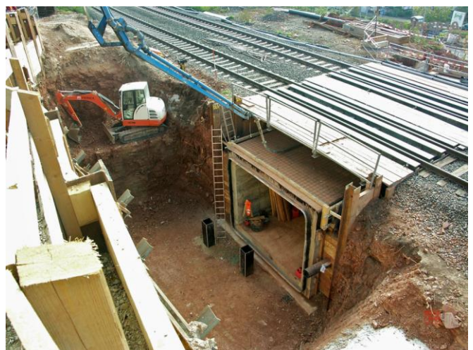
Die Tunnelstückchen sind gesetzt
