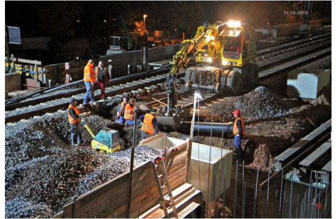
...und die Lasten ruhen jetzt auf der neuen Tunneldecke
