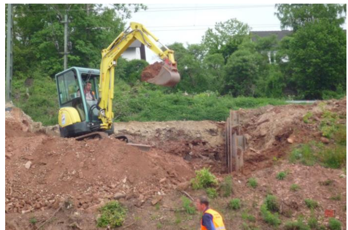
und der Durchstich für die Unterführung beginnt
