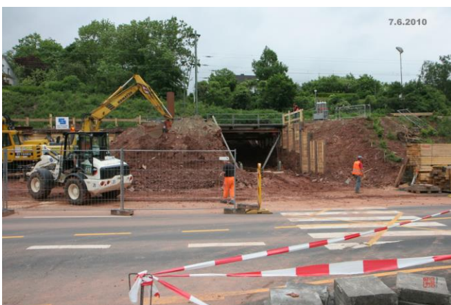
Schon deutlich sichtbar die neue Unterführung
