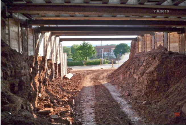
Das Wichtigste ist geschafft (Blick von unten)
