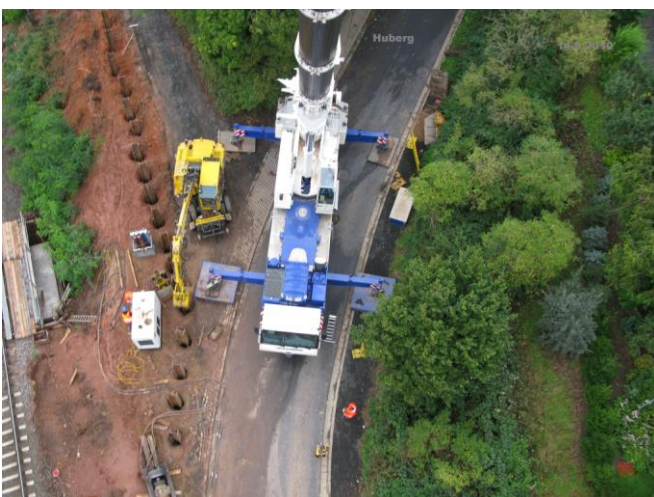
Die Spundwände... Ein Blick vom Kran...
